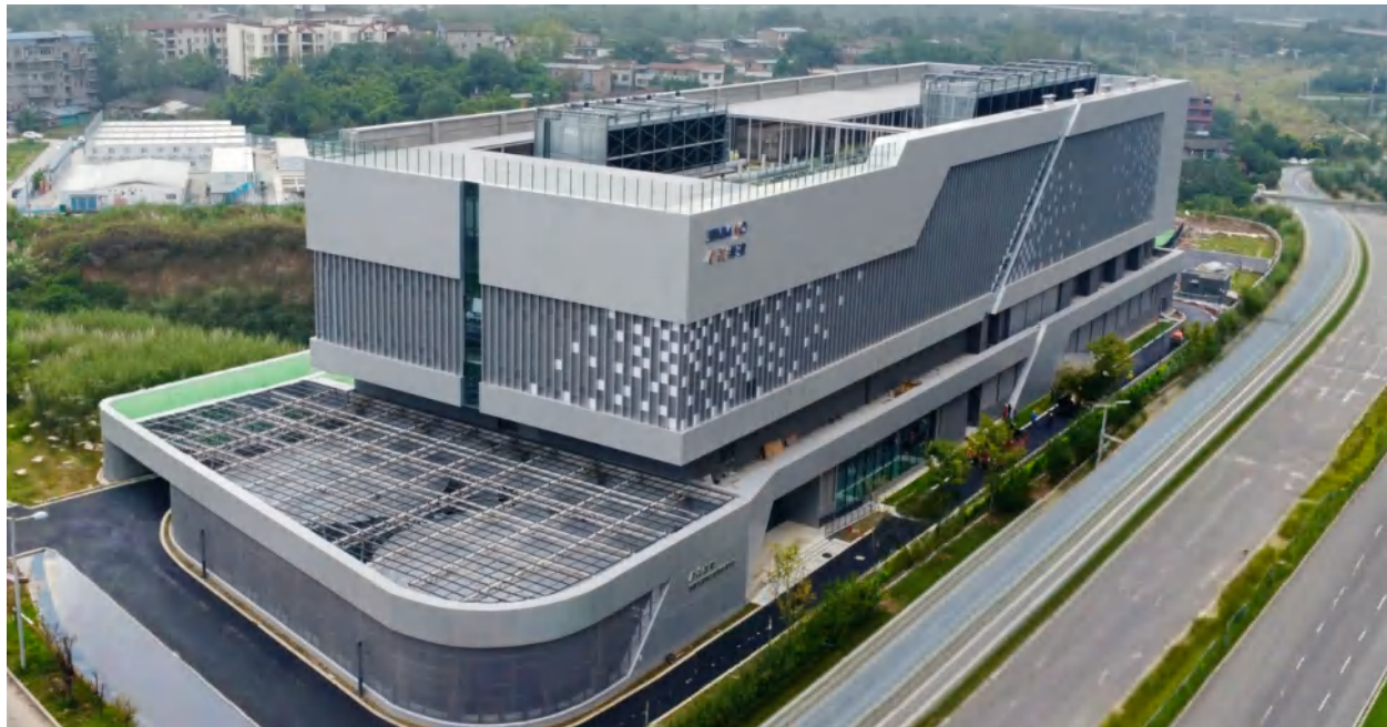
成都天府国际空港新城区域能源站
